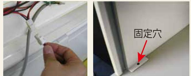
電気配線はコネクタを1本挿すだけ、電源コンセント1本と簡単な施工
